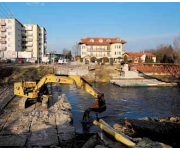
Bager odstraňoval z dna rieky kusy starých pilierov.
