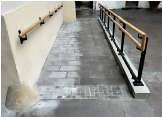
Bezbariérové riešenie pri Nádvorí sv. Juraja po úprave.
