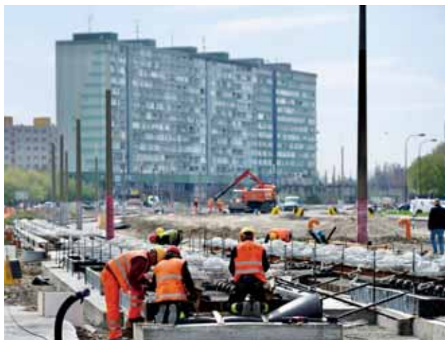
Stavba petržalskej električky. Foto: Marek Velček
