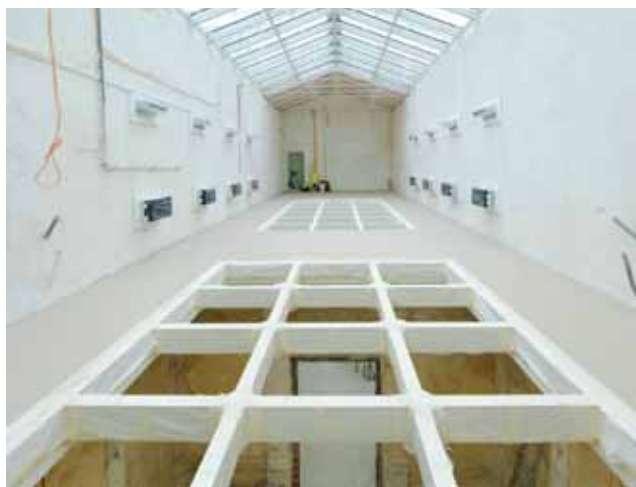
Interiér ZUŠ na Panenskej. Foto: Marek Velček
