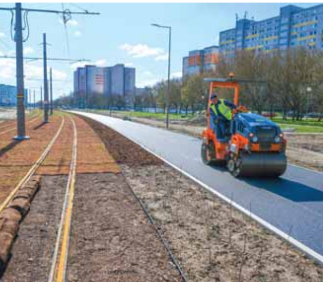
Na stavbe Petržalskej električky prebiehalo veľké asfaltovanie. Foto: Marek Velček
