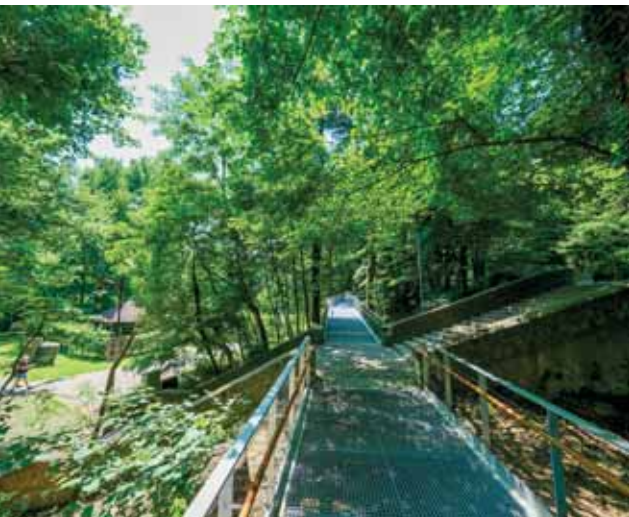
Ocenenie môže získať aj bezbariérová lávka na Partizánskej lúke. Foto: Marek Velčák
