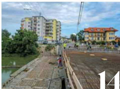
Komplexná modernizácia mosta na Hradskej ulici napreduje
