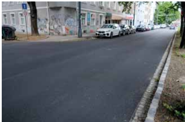
Nový povrch vozovky je aj na Miletičovej ulici.
