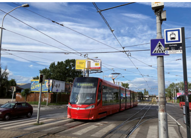
Obnovou prejde aj električková trať na Vajnorskej ulici.
