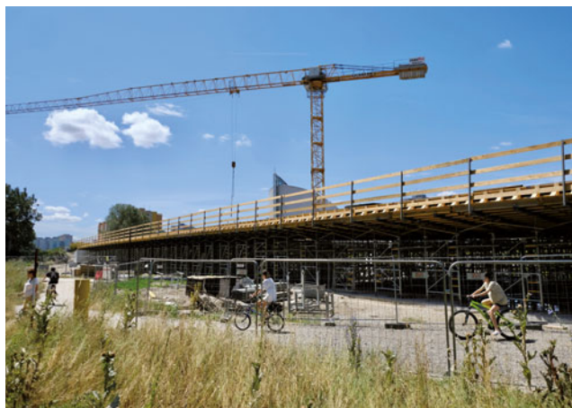
Mostný objekt pri Kostole Svätej rodiny patrí medzi najdôležitejšie časti stavby. Foto: Marek Velček
