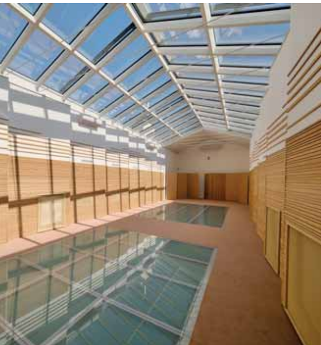
Novinkou je vybudovanie koncertnej sály s krásnou presklenou strechou. Foto: Marek Velčák
