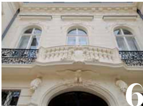
6 V Bratislave ožila ďalšia ikonická stavba. Dom hudby
