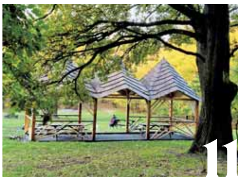
Opravené besiedky a cesty osviežili mestský lesopark
