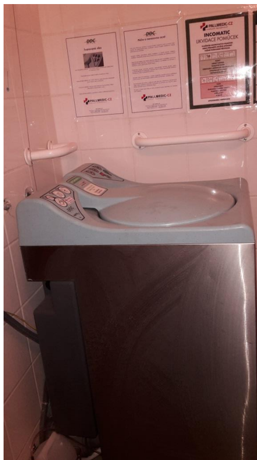
Marzetátor určený na likvidáciu jednorázových inkontinenčných plienok všetkých výrobcov
